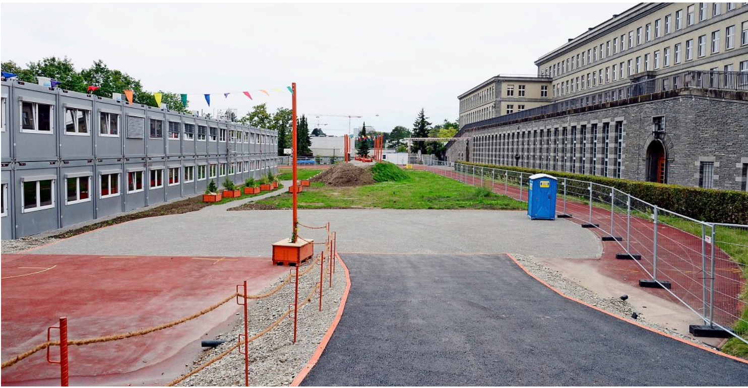
Während der Altbau komplett saniert wird, sind die Naturwissenschaften ins Provisorium umgezogen, andere Fächer ans Obertor. Foto: M. Dahinden
